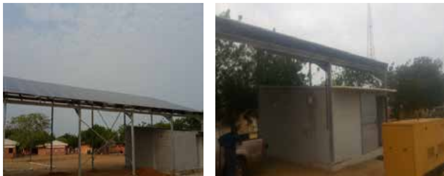
FIGURA 15. Conclusão da montagem da estrutura de sustentação dos módulos fotovoltaicos.
