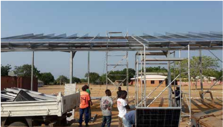
FIGURA 14. Montagem da estrutura de sustentação dos módulos fotovoltaicos e ligação dos módulos.
