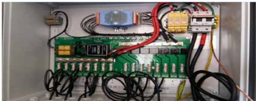
FIGURA 16. String Box – Caixa de conexões que possui fusíveis de protecção, concentra os cabos eléctricos dos conjuntos de 16 módulos fotovoltaicos ligados em série.
