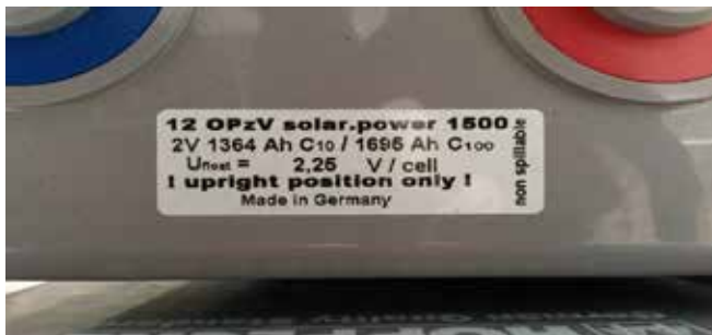
FIGURA 13. Características da bateria 12 OPzV solar power 1500. 1364 Ah C 10 / 1695 Ah C 100 . U Float = 2,25 V/cell.
