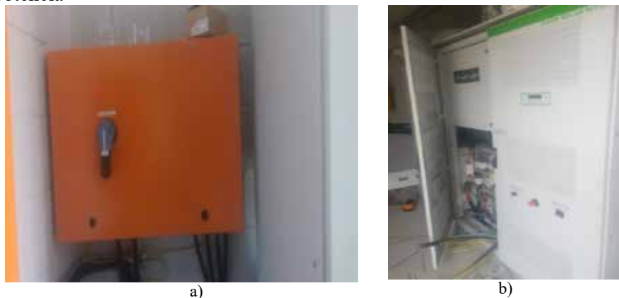
FIGURA 17. (a) Quadro de protecção de corrente (CC): é o quadro que incorpora o primeiro quadro de protecção de corrente (CC) e adiciona uma chave de desconexão do banco de bateria, um dispositivo de protecção contra surtos (DPS), (b) Controlador /inversor off Grid - Zigor Solar HIT3C 100 Plus.
